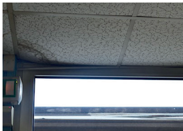
▶ Dalles de faux plafonds
